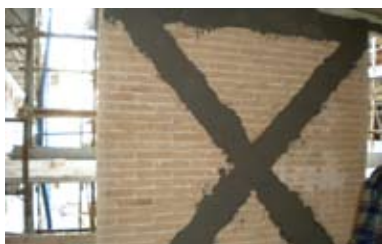
Un particolare del rinforzo, con fibre di carbonio e calce pozzolanica, sulla cortina in laterizio.
