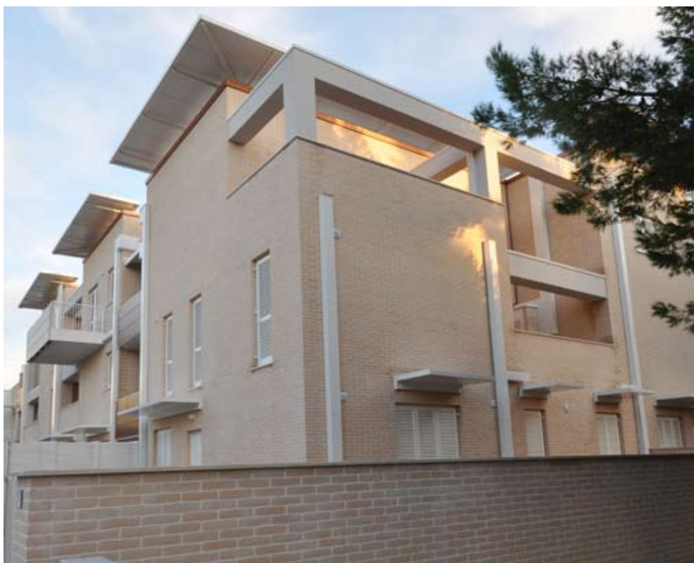
Vista del complesso dal basso.
